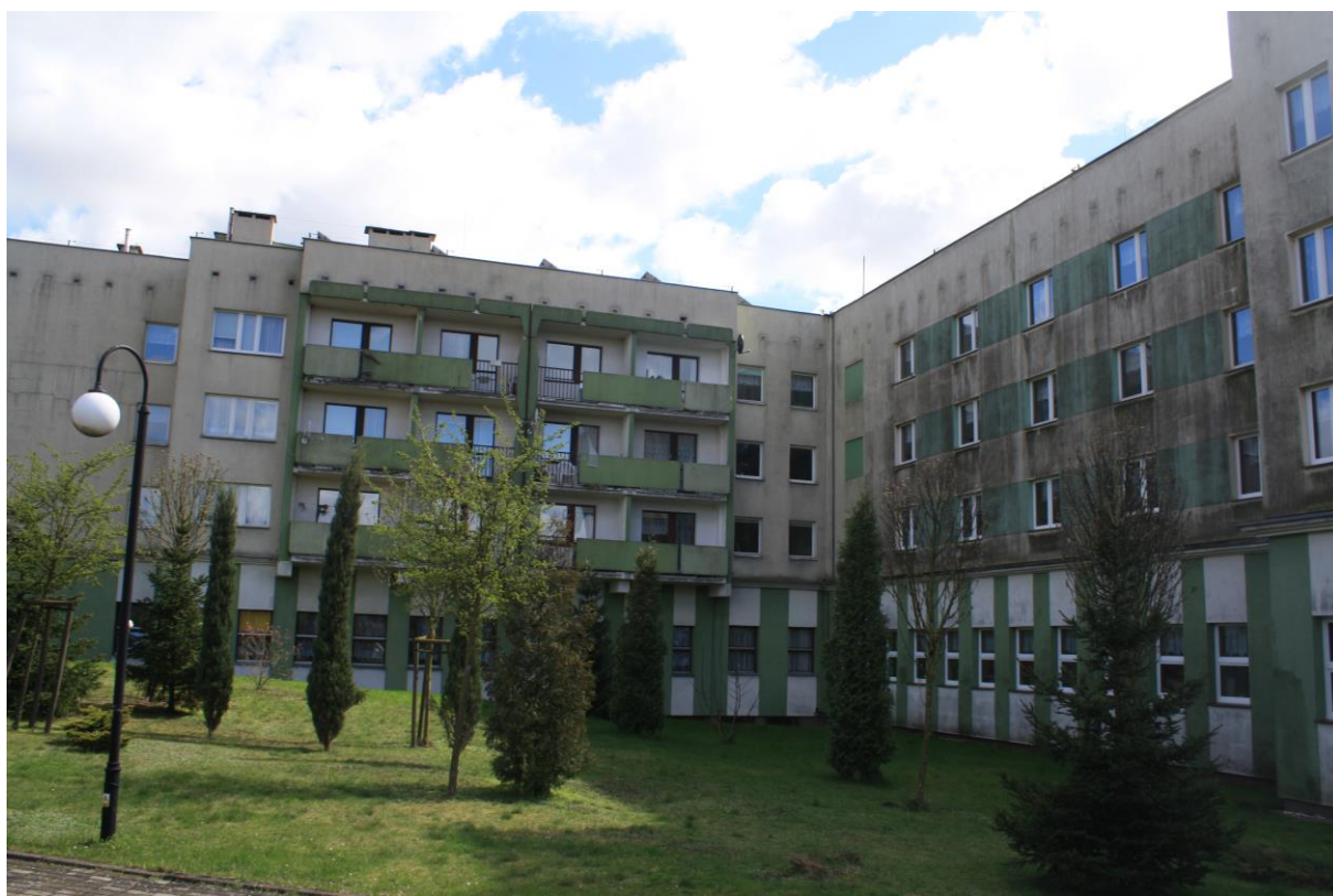
Rysunek 4 Widok obiektu od strony północnej (źródło: zbiory własne, 11-04-2017 r.).
