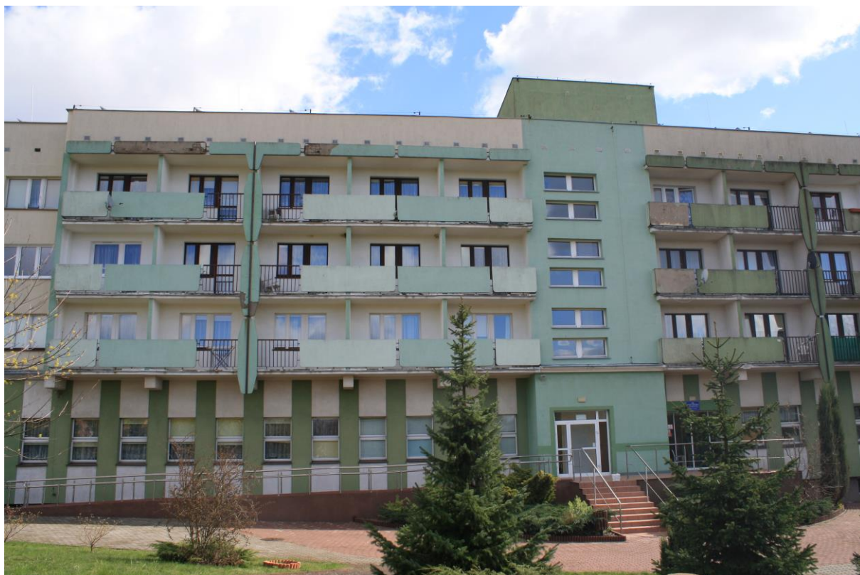
Rysunek 3 Widok obiektu od strony zachodniej (źródło: zbiory własne, 11-04-2017 r.).
