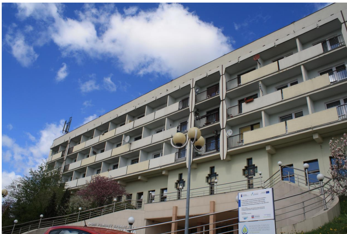
Rysunek 2 Widok obiektu od strony frontowej - południowej (źródło: zbiory własne, 11-04-2017 r. ).
