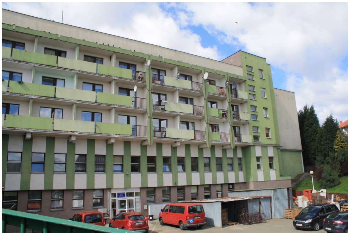
Rysunek 5 Widok budynku od strony wschodniej (źródło: zbiory własne, 11-04-2017 r.).
