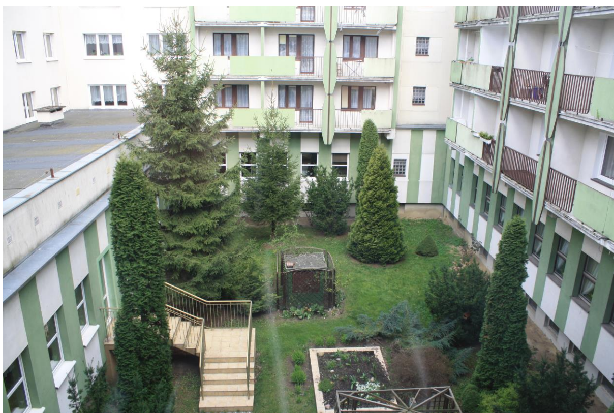
Rysunek 6 Widok na patio budynku (źródło: zbiory własne, 11-04-2017 r.).
